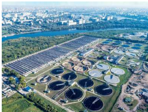
Очистные сооружения, насосные станции, опреснение, водоотведение, канализация, промстоки
